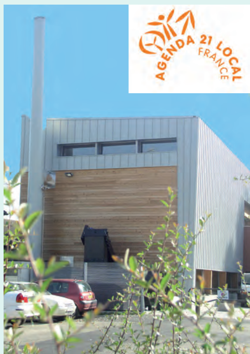
Chaufferie au bois
